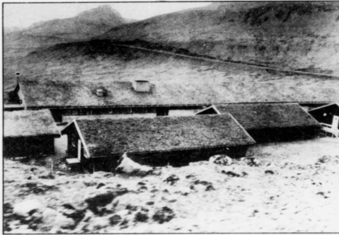
Barakkirnar, ið bygdar eru í Mjorkadali. Tá Tórshavnar býráð viðgjörði umsókn um byggiloyvi kom fram, at sambært matrikkuldómi frá 1980 funnst eingir bygningar har — leigusáttmáli um lendið var ikki komin við í tingbókina. Nú royna danskir myndugleikar at fáa greiði á hesum. Teir hava verið í Føroyum. Men eru ógvuliga sparnir við upplýsingum um málið
