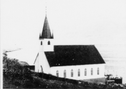
Kirkjan á Húsum er málað við SKALFLEX beton- máling
