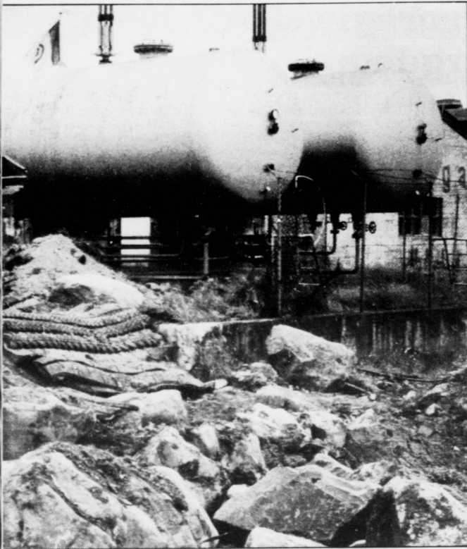
Klokkan var 11.40 tá henda myndin var tikið. Tá var alt klárt til spreingingina, sum skuldi fara fram í dagurðatímanum. Entreprenørirkið helt ikki, at tað var neyðugt serligum trygdartiløkum, tó at spreingikið bert var slakar tveir metrar frá gasstangunum.
