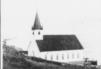
Kirkjan á Húsum er málað við SKALFLEX beton- máling
