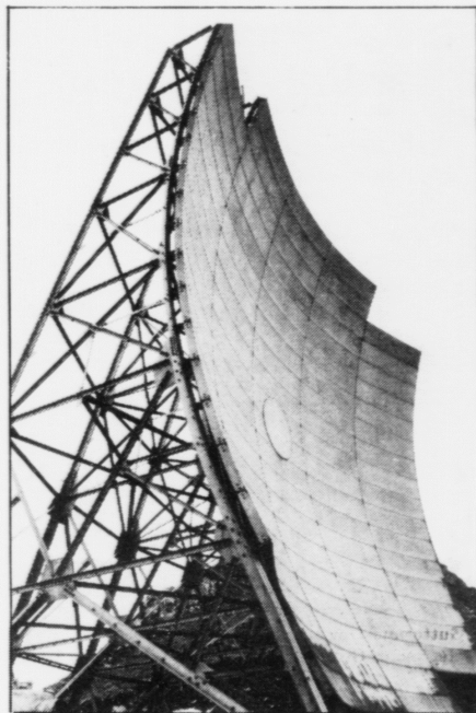
Ein av radarantennunum uppi á Sornfelli.
