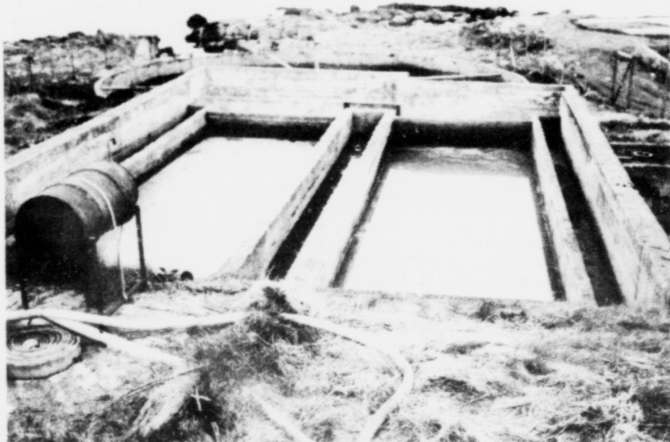
Landssjúkrahúsið hevur eitt reinsiverk, men ikki er líkt til, at tað virkar serliga væl. Har kloakkin rennur út, vóru yvir 100.000 kolibakteriur pr. ml. Í vanligum kranavatni er eingin.
