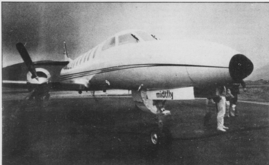
Metro 2-leiguflogfarið, sum Flogfelag Føroya eigur 1/3 í. Tað hevur heimstað í Stauning. Flogfarið hevur tvær turbino-riknar propellir og mesta ferðin 450 kilometrar um tíman.
