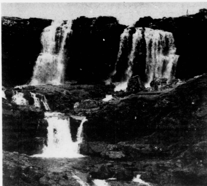
Í Eysturoynni verður hildið fram við vegarbeiðinum til kraftstöðina, ið SEV skal seta upp. Her ein av ánunum, sum skjótt verður turrløgd
