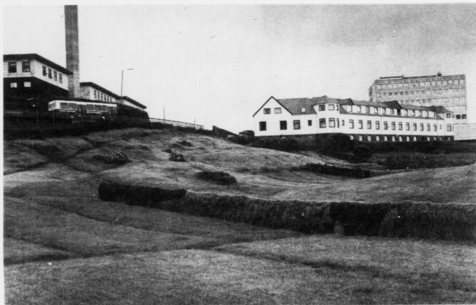
Ætlaði vegurinn fer at liggja tætt uppát gamla hospitalinum og tí nær sjúklingastovnum. Hetta er óheppið, halda mong. Grundin til at vegurinn ikki kann leggjast longur burt frá bygningunum er tann, at Sandagerðsbøurin er friðaður
