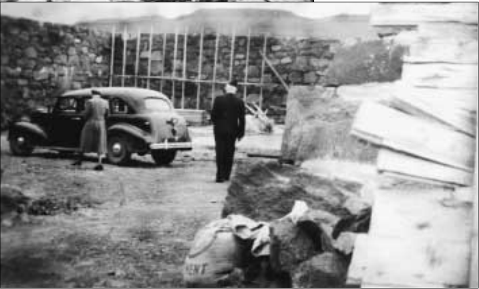
Inni í vatnbrunninum undir Gráasteini í Havn undir krígunum. Teir hava latið vatnið úraftur nýggja brunninum, sum lak í eyri og seyri. Arbeiðið við at støypa gólv og veggir er farið í gongd. Bilurin á myndini hevur nummarið 38, maðurin er Edvard Bærentsen, skómakari
