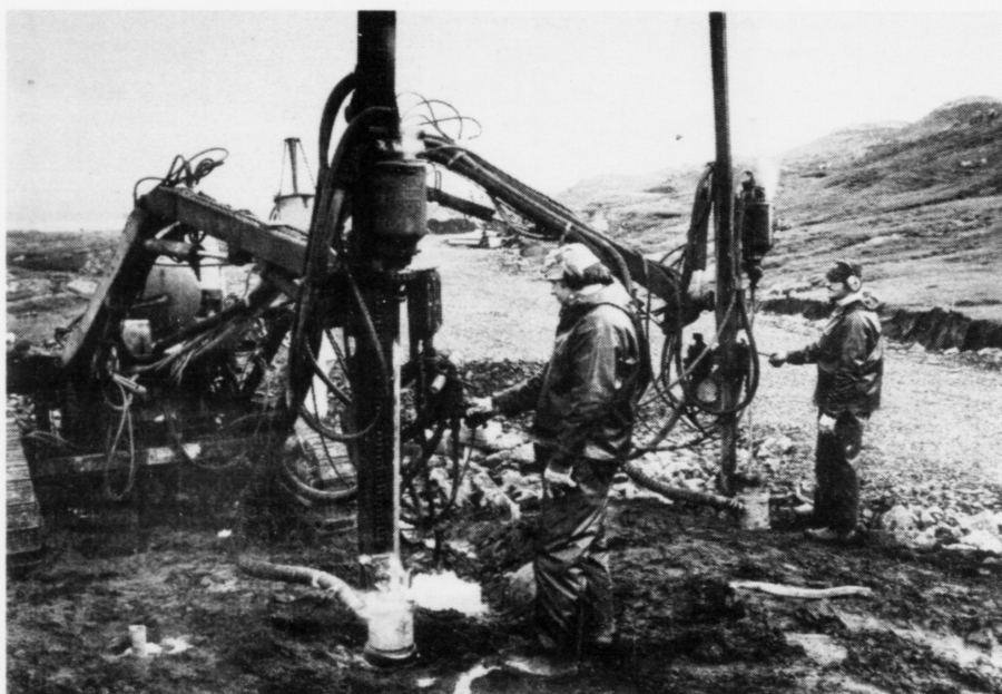
Hol sett á. Vegurin til ætlaðu brennistøðina hjá Tórshavnar kommunu á Sandvikarhalla er gjørdur, og í vikuni fóru teir at bora fyri sjálvari brennistøðini. Tað er byggi-felagið Guttesen & Staksberg, ið stendur fyri arbeiðnum.
