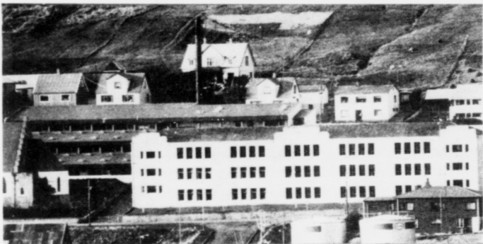
Tey, sum verða boðsend til forhoyrið, hava skyldu at svara spurningum um, hvat er á vasi innan fyri betongveggirnar í Vágs skúla.
