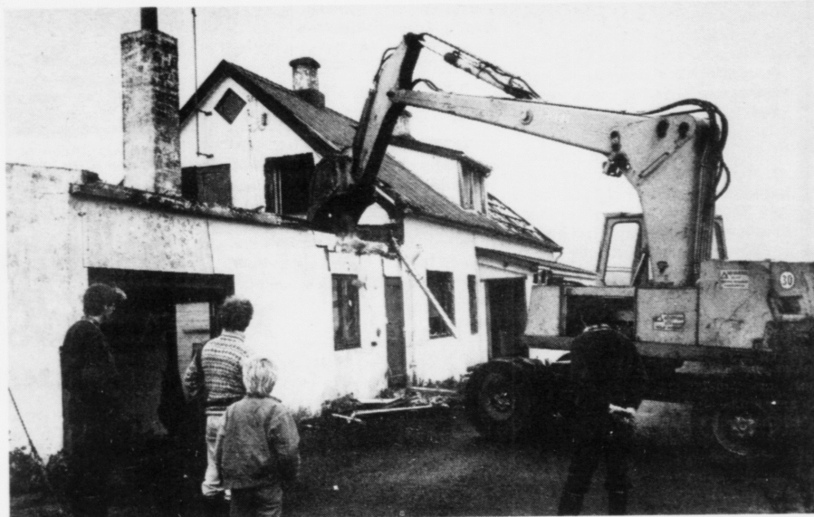
Doktarahúsini á Sandi blivu brotin niður í síðstu viku og nú skula nýggj hús byggjast á sama stað
