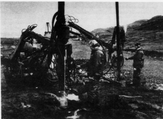
Tað liður væl við vegnum niðan á Sandvíkahjalla og um ein mánað verður farið undir at grava út fyri bygninginum hjá P/f Kommunala orku- og brennistøði
