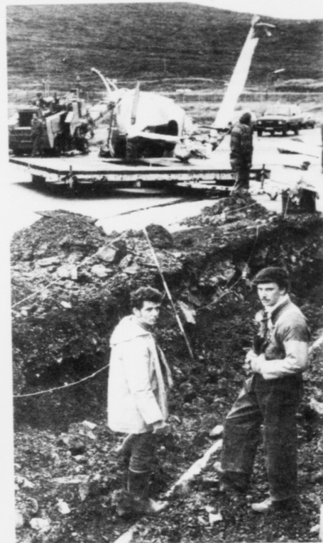
Seks arbeiddsmenn fingust við at leggja rør niður nakrar fáar metrar frá, har Snípan datt. Vildi illa til lógu teir undir tyrluni
