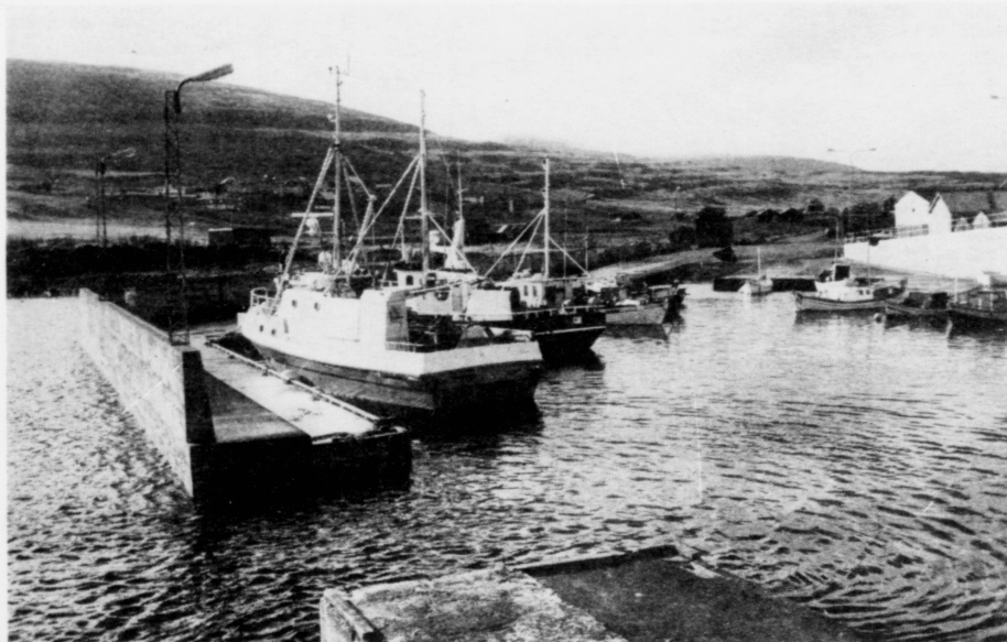
Bátahylurin, har opnir bátar og smærri fiskifør kunnu liggja
