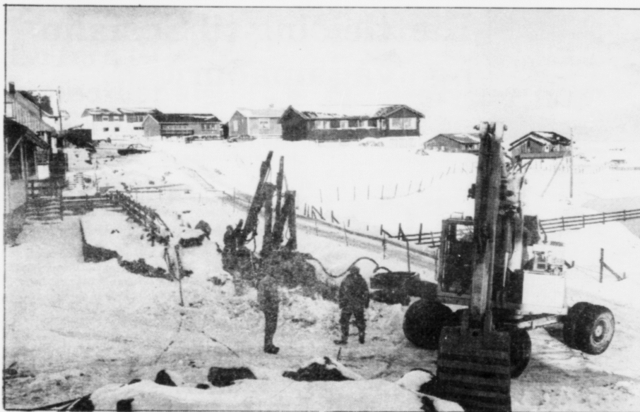
Arbeitt verður enn við at breiðka nðasta part av Villingardalsvegnum. Og Tórshavnar kommuna kann ikki krevja, at tey, sum hava bygt við vegin, skula gjalda helvtina.
