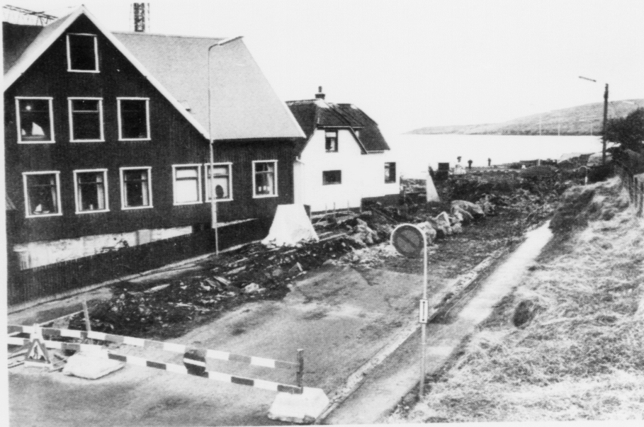
Meira sprengiarbeiði, ifylla og stoyping eru høvuðsorsøkirnar til at arbeiðið hevur tikið so langa tíð
