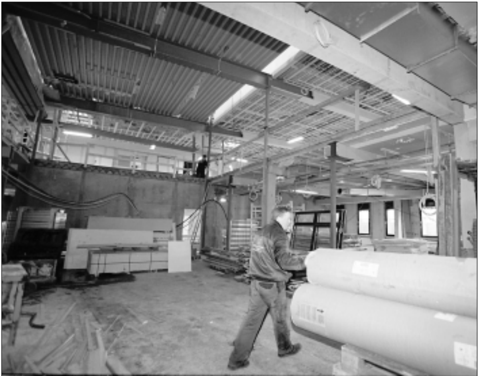
Gamli fiskasølubygningurin er hamskiftur uttan og innan er nærum alt skrætt niður, fyri síðani at vera sett upp aftur á annan hátt. Teir arbeiða við fullari ferð yviri við Strond
