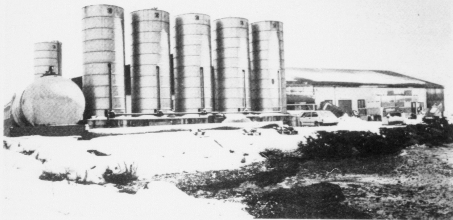
Stór útbygging er framd á Bakkafrost. Her eru nakrir av tangunum, sum súrløga til alifóður verður goymd í
