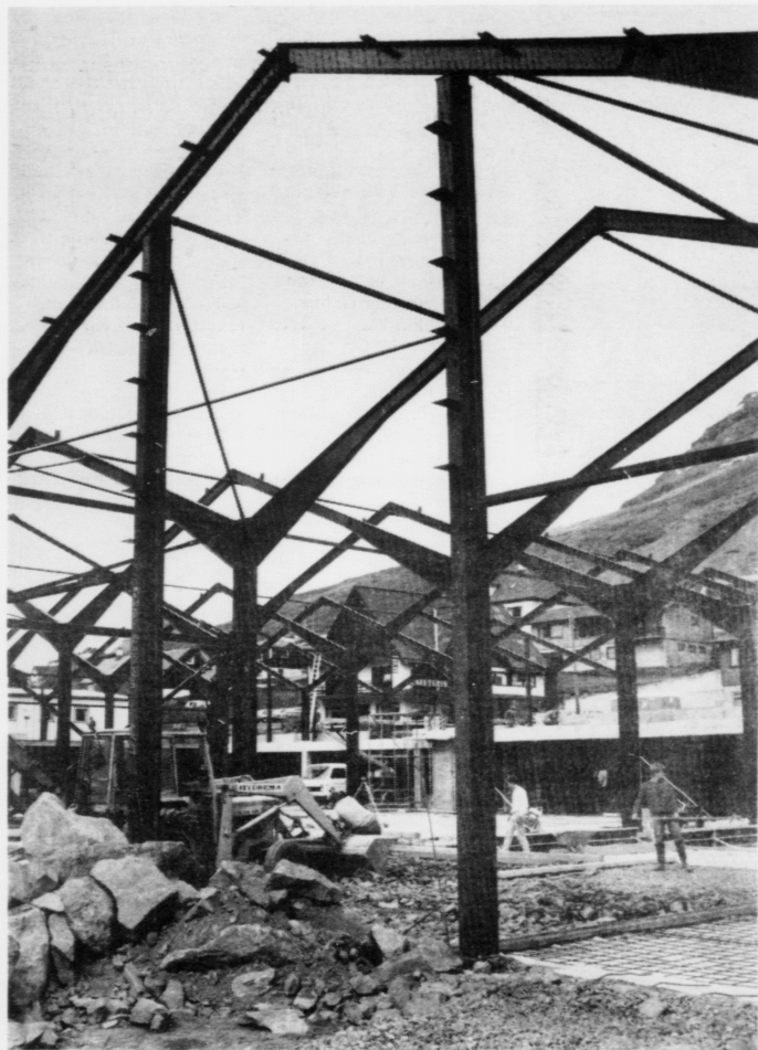
Stálkonstruktiónin til fyrra byggistig varð reist eftir einari viku
