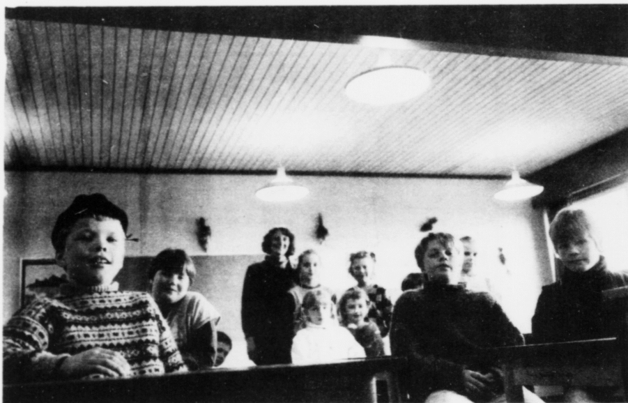
Í Argja skúla lúður nú væl við arbeiðinum at leggja nýtt loft og luftskiftisskipan.
