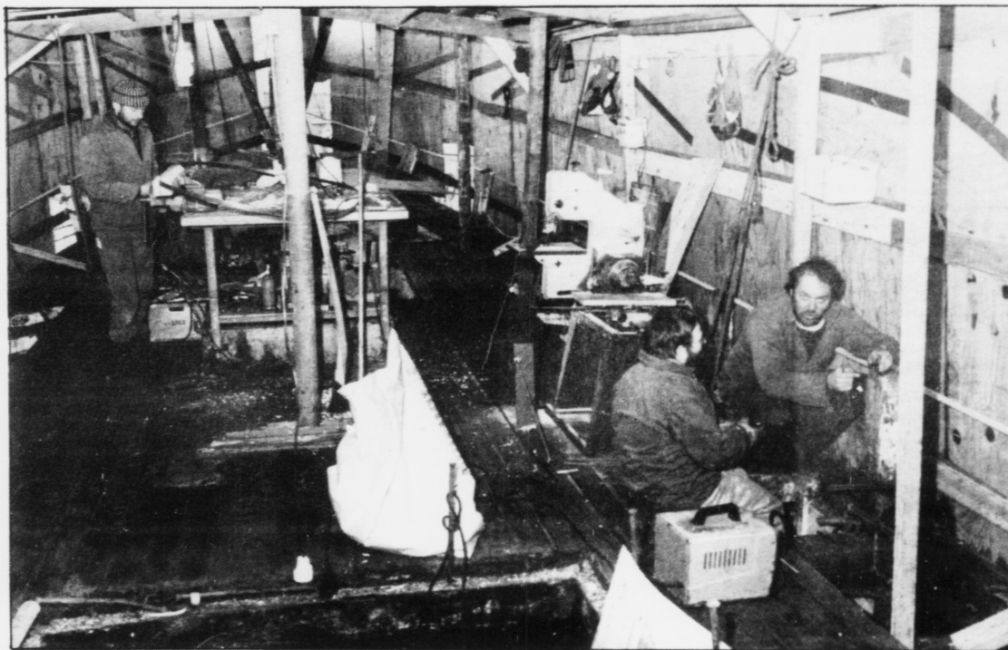
Nú verður arbeitt við leggja nýtt dekk í skipið
