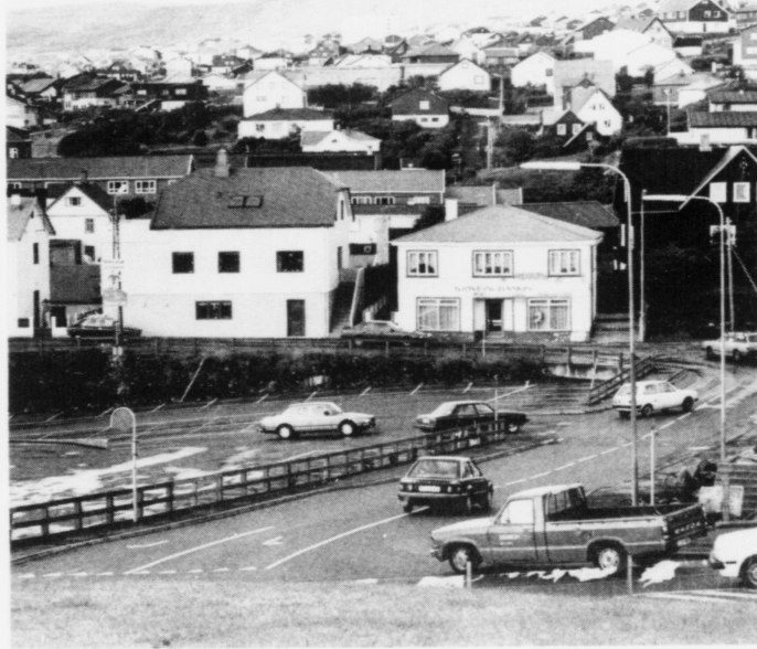
Soleiðs sá út, áðrenn arbeiðið at víðka parkeringsplássid byrjaði. Nú er alt okið grivið upp tætt upp at húsunum, so fólk hava ílt við at koma til og frá
