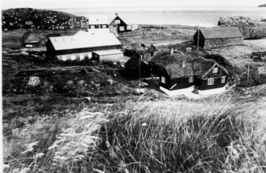
Í vár flutti Fornminnisavnið arbeidsholi síni niðan í bygningarnar hjá Royndarstöðini í Hoyvík. Seinni skal alt fornminnisvirksemið hjá savninum niðan á Hoyvíksgarði
