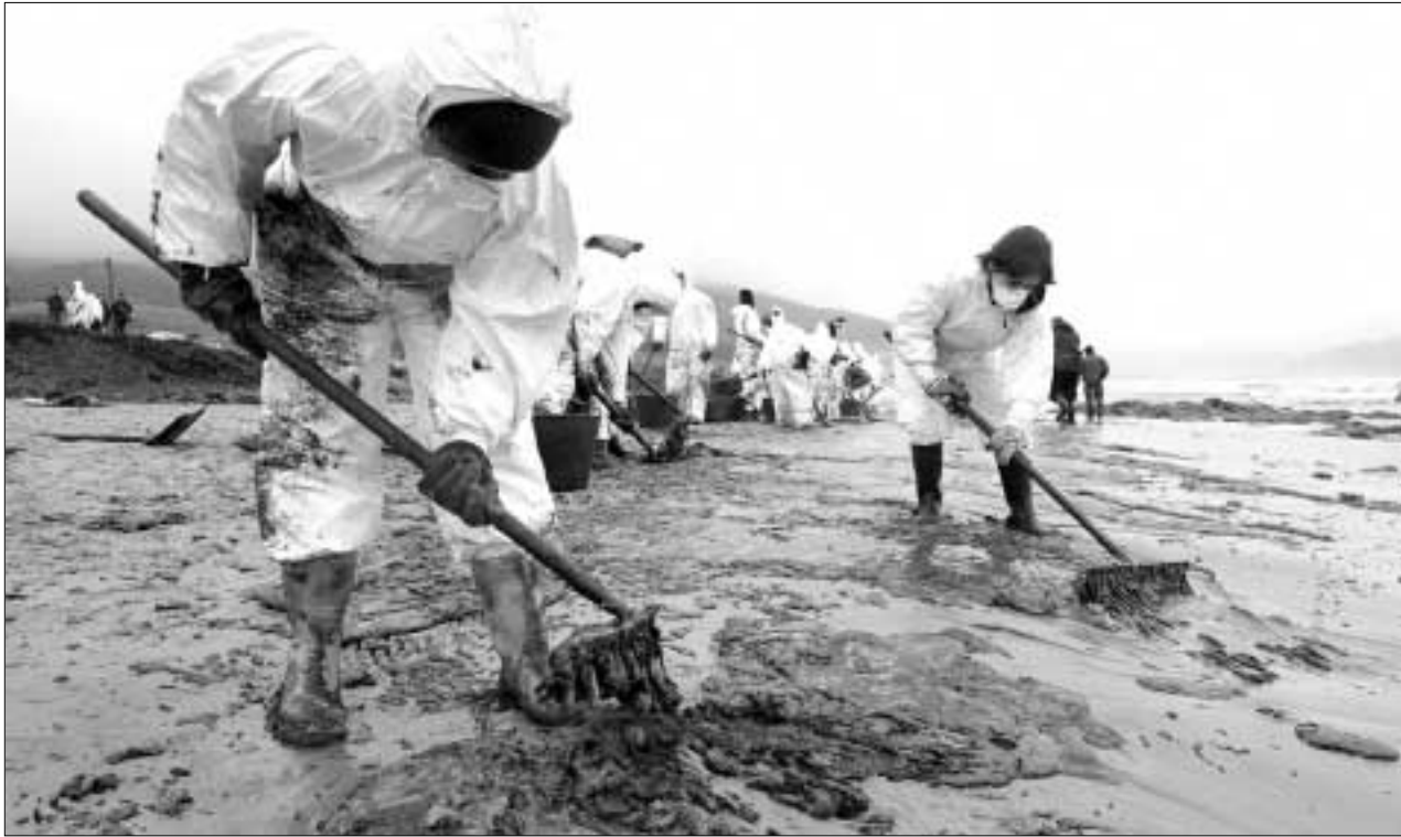
Sunnudagin vóru nógv sjálvboðin og tóku olju upp í fjøruni í útnyrðingspartinum av Spania, men arbeidið tykist næstan nyttuleyst, nú tað ljóðar, at nógv meiri olja er á veg inn ímóti landi.
