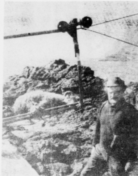
Luftfærden er over
