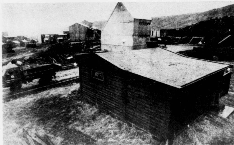
Andveikraverndin skal byggja á stykkinum oman fyri vegin. Stykkið er umleið 900 fermetrar og Landsstýrið hevur keypt frá manninum, sum eigur summarhúsið á stykkinum.
