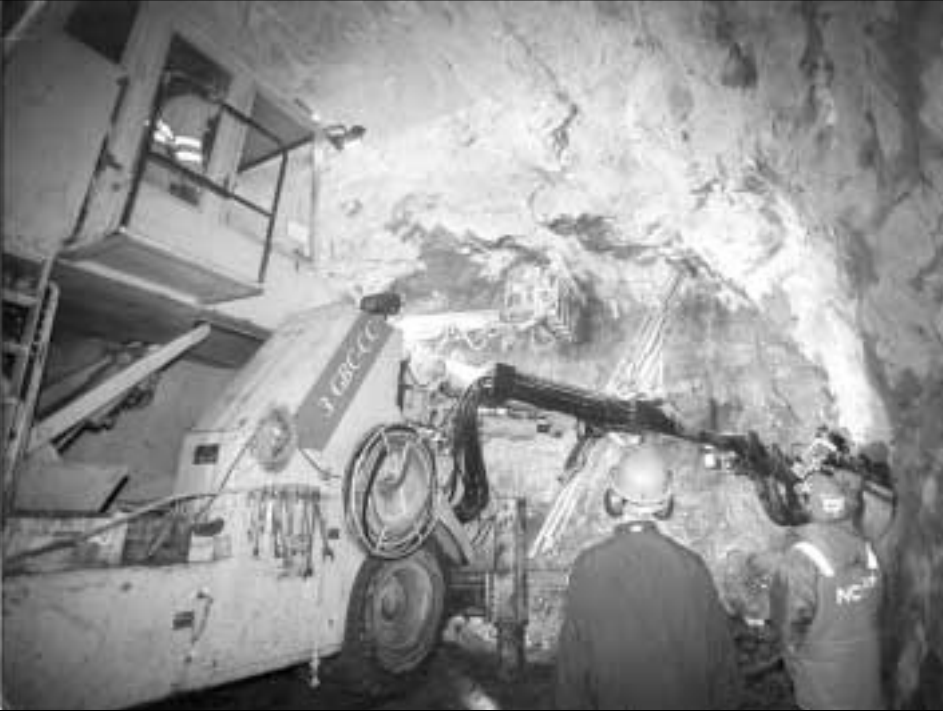
Tað kemur at taka uml. 10 ár at bora ein tunnil til Suðuroyar
