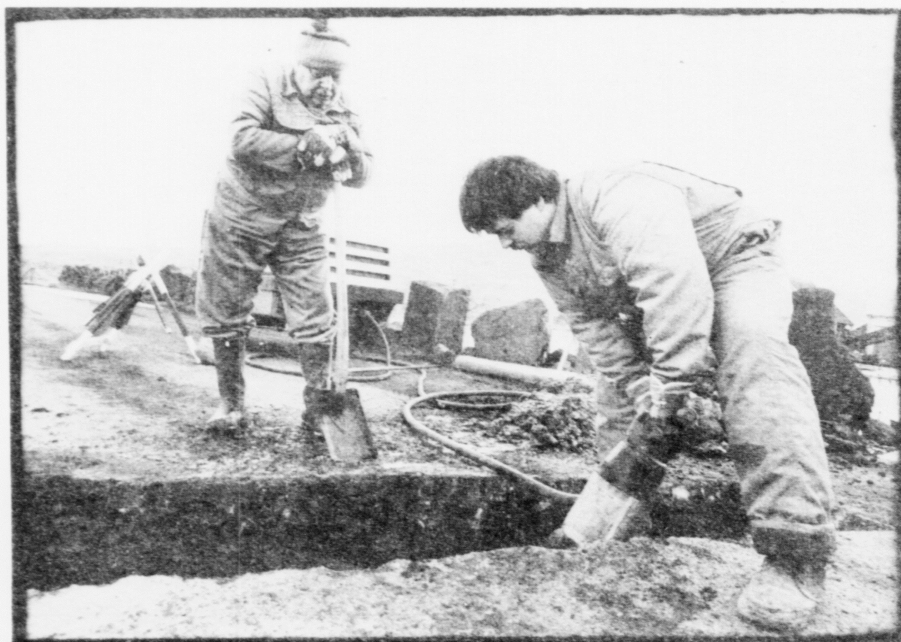
Ofta er neyðugt at kvetta vegir av fyrri at koma niður til rørin
