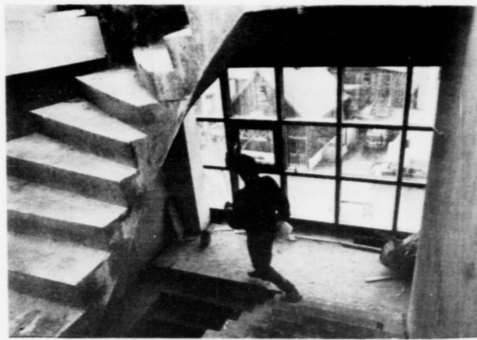
Uttan er um at vera lidugt, men innan er nógv eftir at gera. Enn er onki innrættað. Men byggharrin er visur í, at tíðarættanin heldur, tí hann hevur longu sent út innbjóðingar til upplatingarmóttøkuna tann 15. november.
