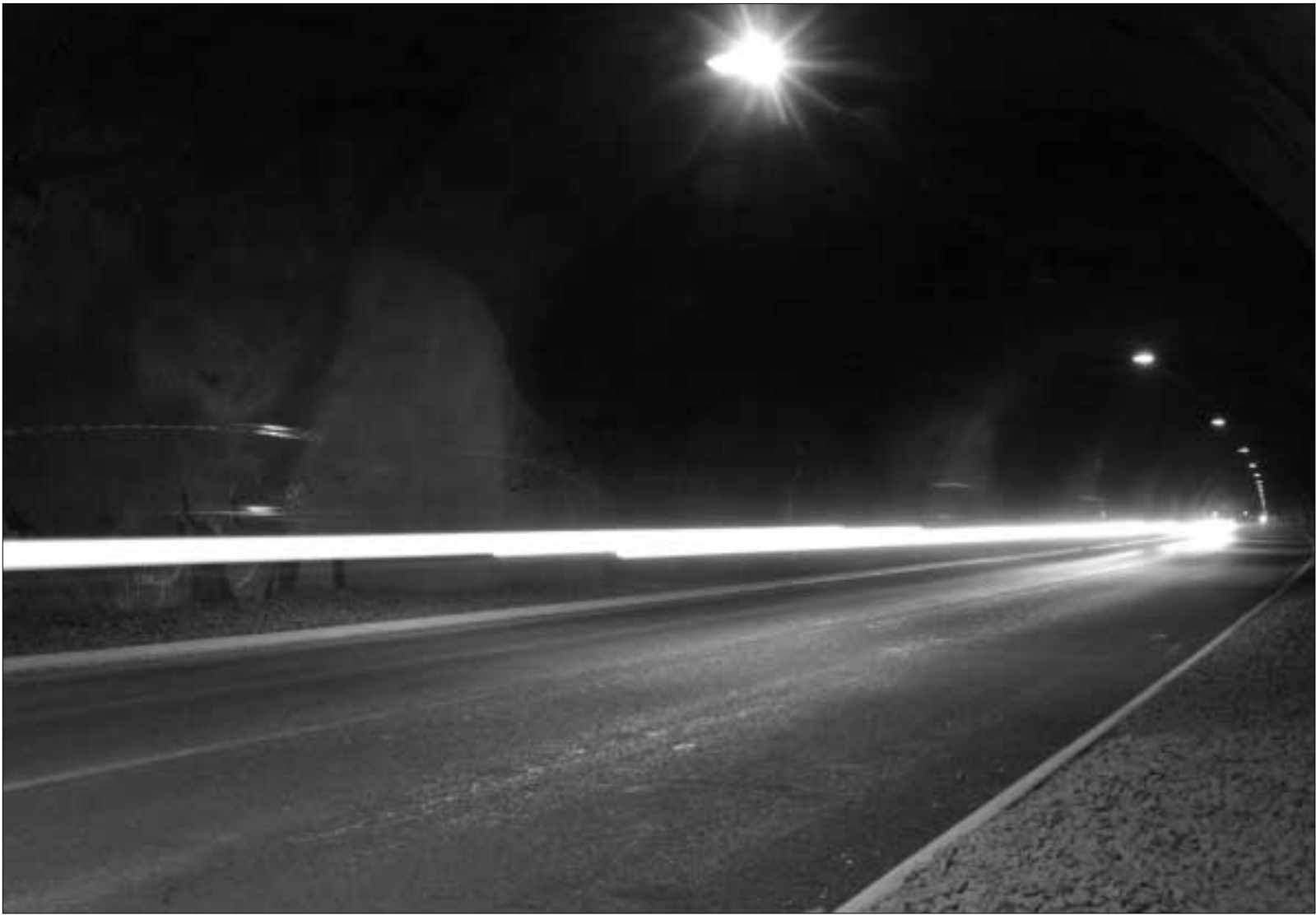
Hóast jólagestirnir eru farnir av aftur landinum, og hálka eisini hefur verið part av farna mánaðinum, koyra nógvir bilar gjøgnum Vágatunninlin. Meðaltalið liggur um 700 bilar um samdøgurið, og tá mest hefur verið ein friggjadag, hava teir verið upp móti 900
