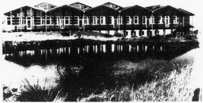
Skulabygningurin við Marknagilsvegi í Havn, bygdur í 1983
