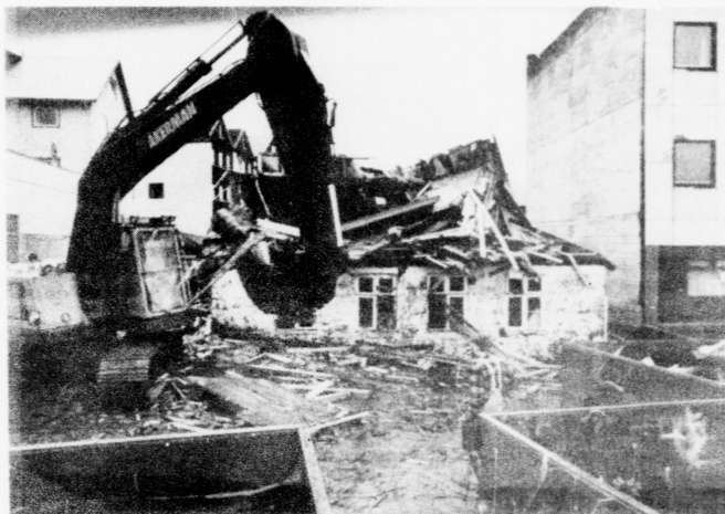
Hósdagin varð gamla húsið í Jónas Broncksgøtu brotið niður. Um stutta tíð fer Smyril Line at reisa eitt hús úr betongelementum á grundina
