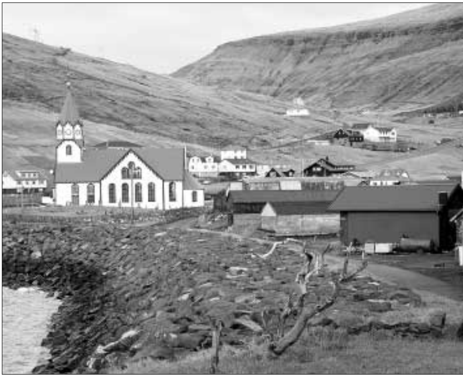
Trupulleikar hava verið av, a t frárenslíð undir grótkastinum er typt, og vatnskaði hevur staðist av. Í vár verður hol sett á garðin, og nýtt frárensl lagt, áðrenn grótið so verður lagt aftur
