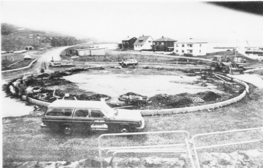
Líðugt er at seta kantsteinar upp, og í næsti viku verður asfalterað
