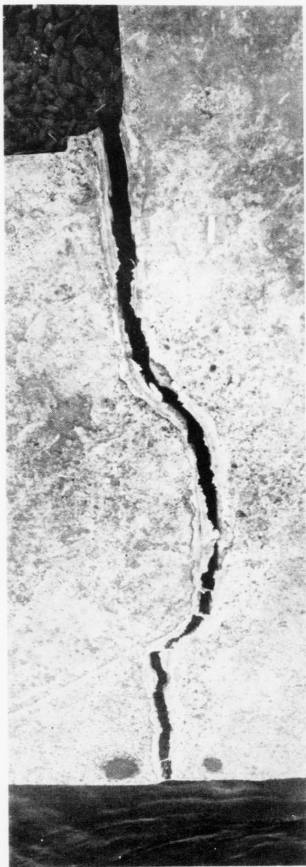
Myndin sýnir rivurnar í nýggju bryggjuni við Prestlandið í Miðvági. Tað eru hesar rivur fólk óttast. Men arbeidsformaðurin Bjarti Mørkøre sigur, at ongin vandi er fyri at bryggjan søkkur. Mynd: Kalmar
