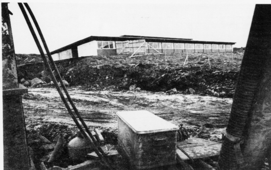
Nú í januar mánaði varð arbeiðið við at byggja uppí Hoyvíkar skúla tikið upp aftur. Mynd: Kalmar
