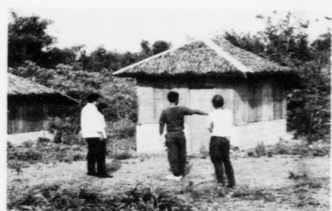
Soleiðis síggja húsini í Faroe Village á Filipsoyggjunum út. Tá bygdin er liðug, vera tey 50 í tali.
