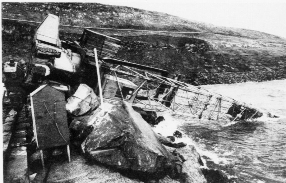
Hevði kranin koppað inn móti landi, kundi verið verri vordíð við manninum, sum sat í krananum. Mynd: Kalmar
