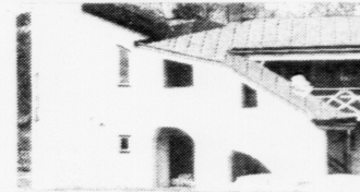
Eitt dømi um byggilist
