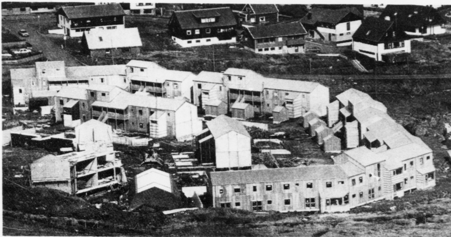
Tey, sum búa í fyrsta byggistigi á Berjabrekku, sleppa nú frá stóru rokningunum í sambandi við, at byggingin gjørdist so nógv dýrari
