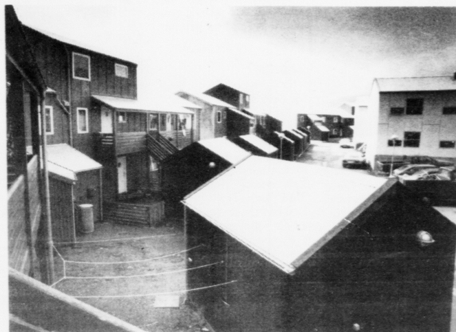
Í árávis hava tey í fyrsta byggistigi á Berjabrekku togast við býráðið, tí tey vildu ikki gjalda fyrri, at byggingin var ovurhonds dýr. Nú gevur býráðið eftir.
