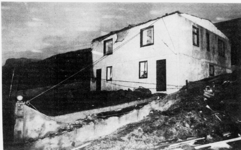
Stormurinn hefur verið harður, tá húsini kundu fara so illa
