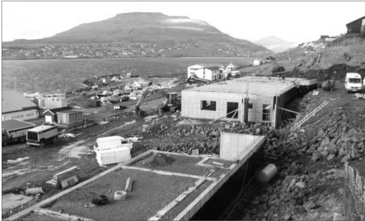
Nógv bygging fer fram innanfyri Føroya Banka á Toftum í hesum døgum. Fremra grundin á myndini er nýggja húsið, Nebo, hjá brøðrasamkomuni í Nes kommunu; seinna og norðrara grundin er eldrasambýlið, sum Nes kommuna letur byggja.
