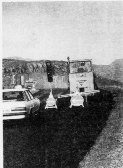
Sambandsflokkurin vil hava, at privatu feløgini kappast um nýgerð og umvæling av millum øðrum landsvegnum. Mynd: Kalmar
