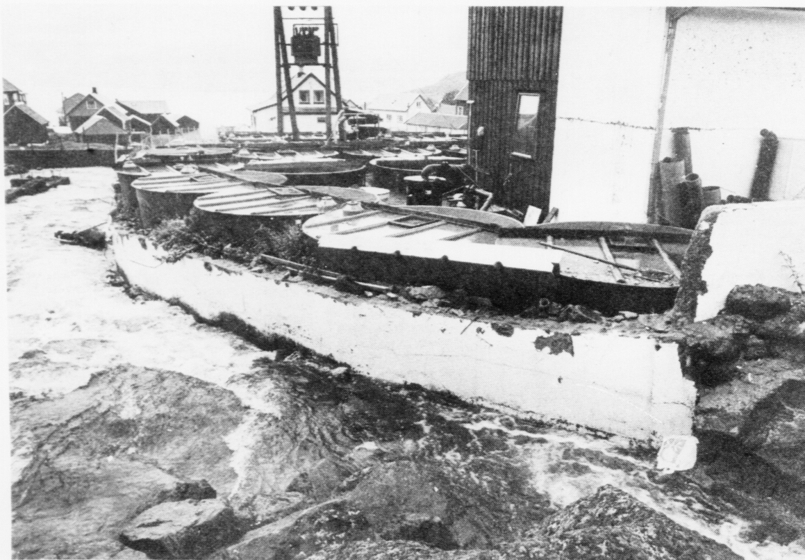
Kørinu standa enn og farið er undir at bróta garðin niður. Mynd: Kalmar
