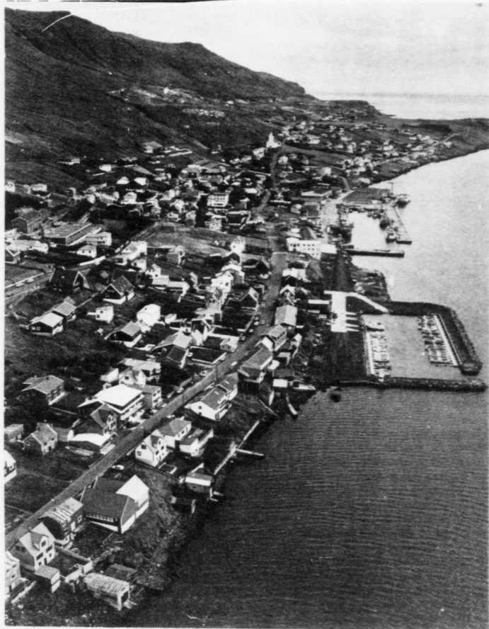
Á Tvøroyri er nógv arbeiði í løtuni. Flakavirkið hevur arbeiði hvønn dag, teir byggja sjúkráhusið og ymist annað byggivirksemi er. Men tey, sum arbeiða hjá kommununi, mugu bíða leingi eftir lønini
