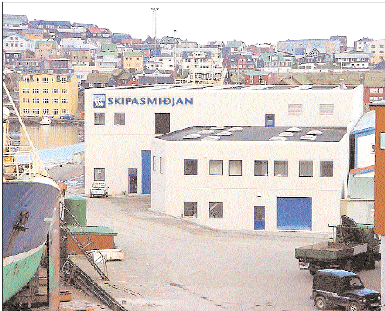
Nýggi og stásiligi bygningurin hjá Tórshavnar Skipasmiðju, sum er reistur, har gamli Fiskasentralurin var, fer at tæna bæði Skipasmiðjuni og viðskiftafólkum hennara.
