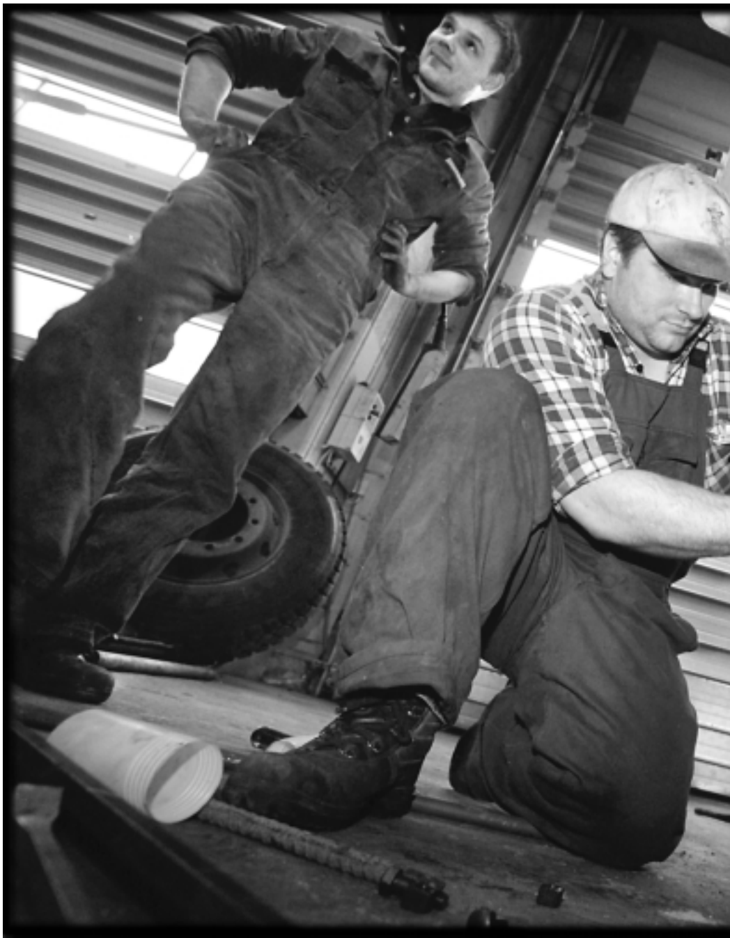
Eyðbjørn Johansen umvælir eina asfaltmaskinu, sum skal vera við til at tryggja føroyska ve
